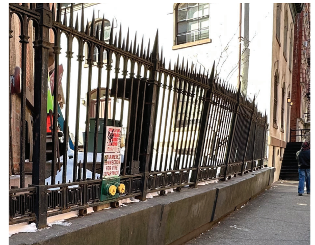
A35 - RESTORE SITE FENCE
